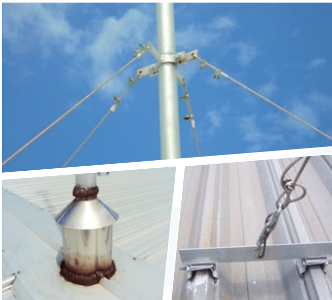
ตรวจสอบรอยเชื่อมต่อ และจุดยึดระหว่างสายสลิงและเสา
