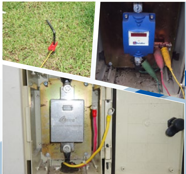
ตรวจสอบสภาพความสมบูรณ์ และวิเคราะห์ค่าความต้านทานหลักดิน
